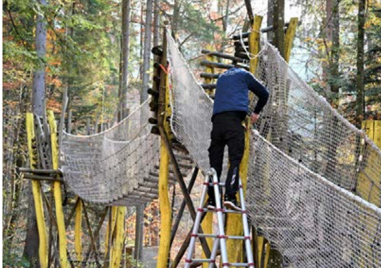
Unterhaltsarbeiten am «Vogelnest», dem Mittelpunkt des Holzweg Thal
