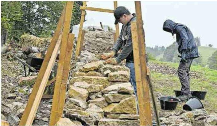
Mittels Holzrahmen werden Länge und Höhe der Mauer festgelegt.
